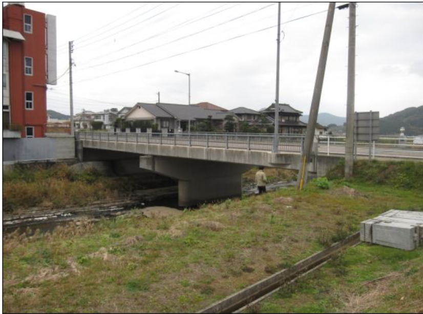
16) 設計現場16 現道拡幅: 交通量が多く、現橋護岸を壊さずに施工できるように計画
