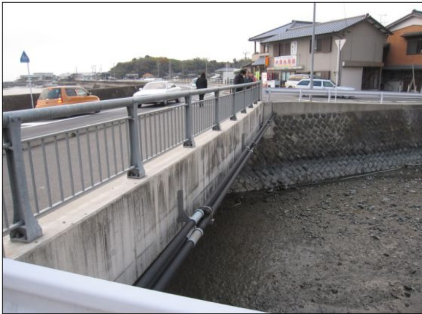
16) 設計現場16 現道拡幅: 交通量が多く、現橋護岸を壊さずに施工できるように計画
