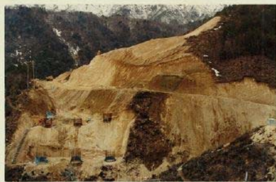
2) 現場施工状況 ラーメン式橋台の支保工風景、凄い支保工でした。計算難
