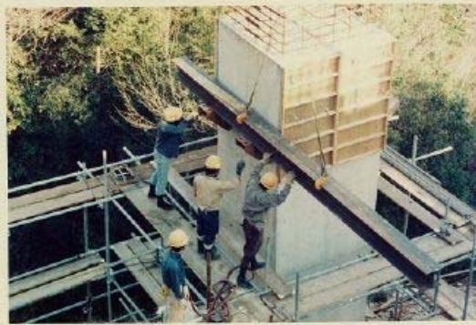
2) 現場施工状況 ラーメン式橋台の支保工風景、凄い支保工でした。計算難
